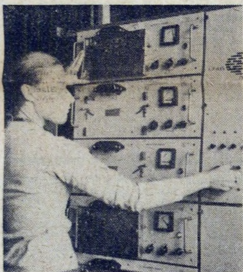
Cała tajemnica nadawanych programów tkwi w tej oto aparaturze. Jak widać, taśmy nie są nawinięte na szpulki, jak w normalnym magnetofonie, lecz znajdują się w pozornym nieładzie, w prostokątnych kasetach.
