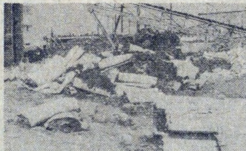
Budowa „przewodzona” przez PBM. Blok 507 w Bieńczykach. Świetna to ilustracja kosmicznego bałaganu.
