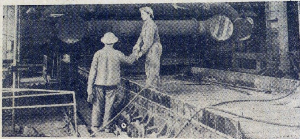
Przy montażu urządzeń taśm spiekających.
