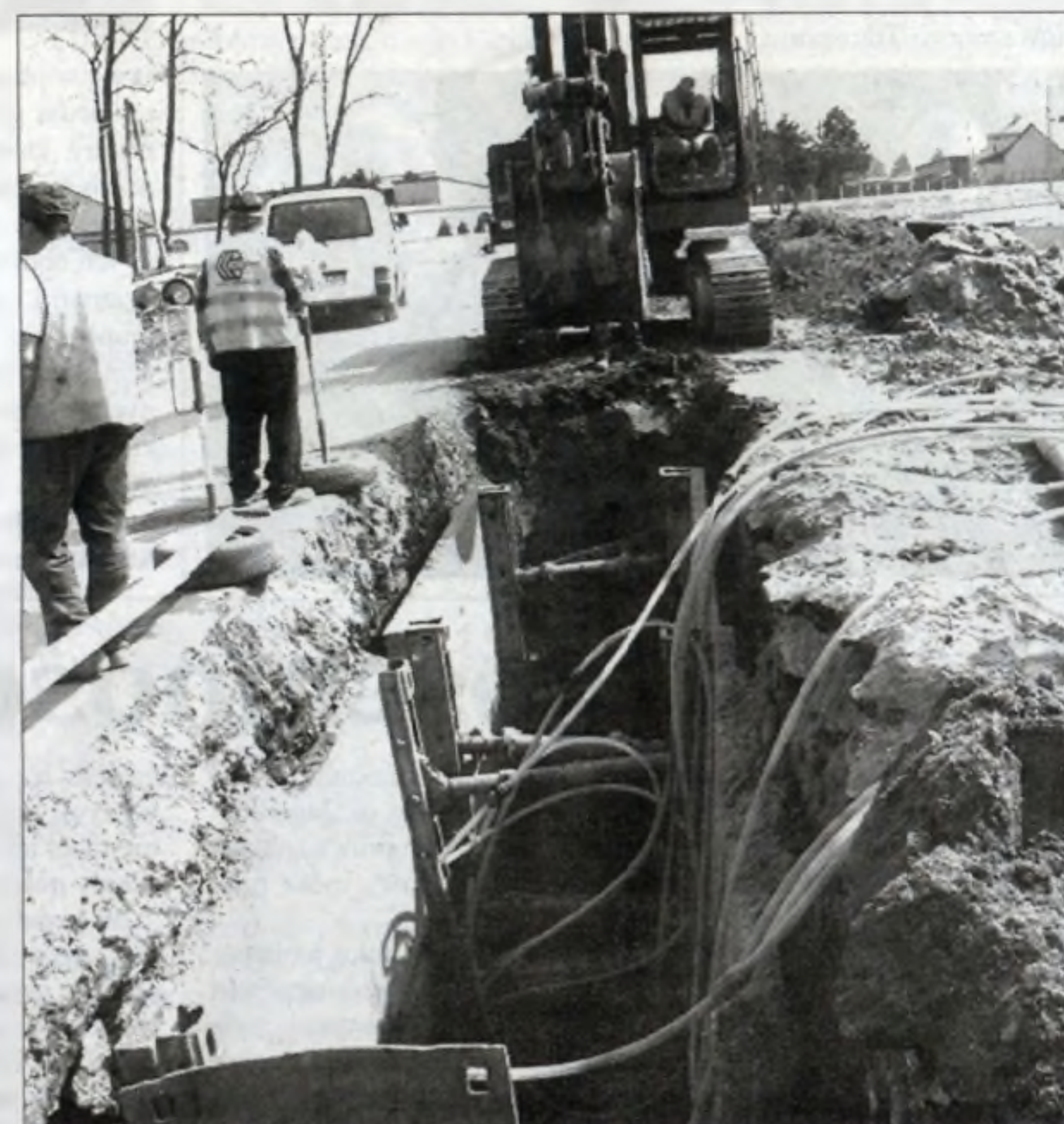
Odwadnienie wykopu przy ul. Rzepakowej.
