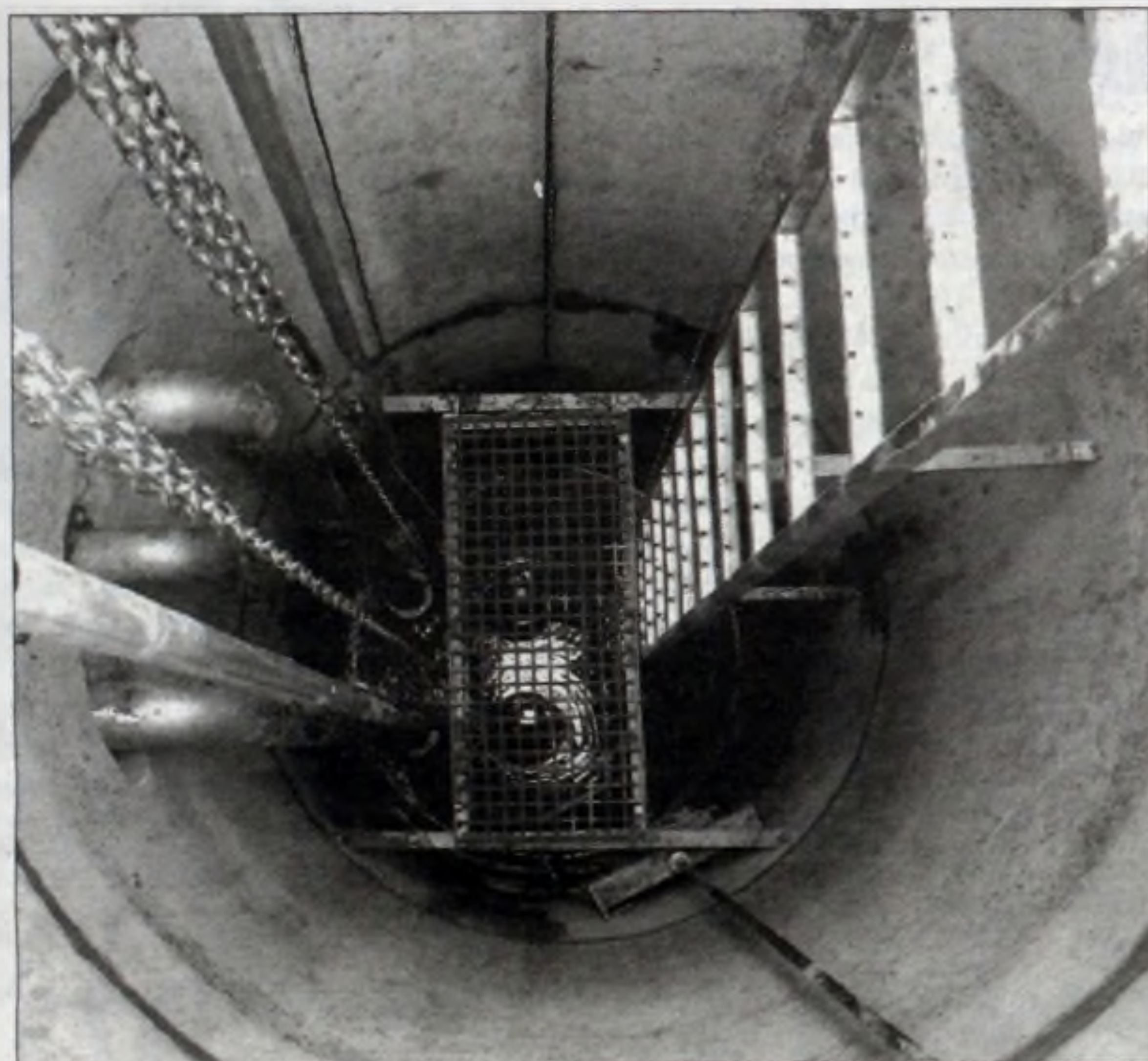
Wnętrze przepompowni P13 (na ul. Truskawkowej) zlokalizowanej na kanalizacji sanitarnej wybudowanej w ramach projektu „Gospodarka wodno-ściekowa w Krakowie – Etap I”. Zadanie „Budowa systemu kanalizacji sanitarnej we wschodnich rejonach miasta Krakowa (Dzielnica Nowa Huta)”.
