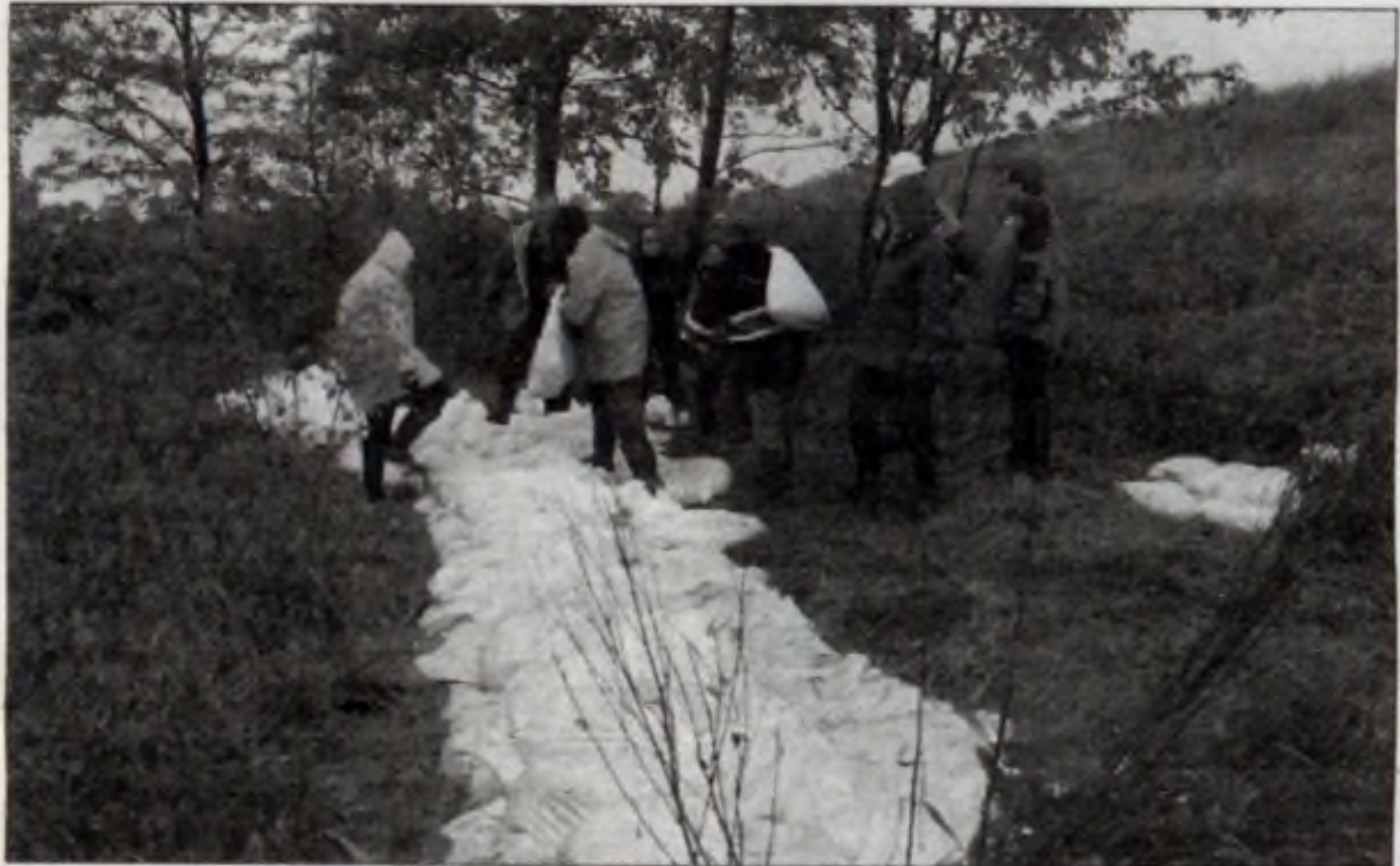
Uszczelnianie wałów kanału Suchy Jar podczas powodzi w 2010 roku.
