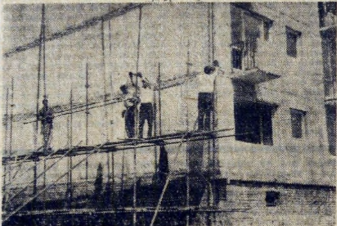
Roboty tynkarskie posuwają się szybko naprzód, budynki niedługo już nabiorą estetycznego wyglądu. Foto: J. Brózek
