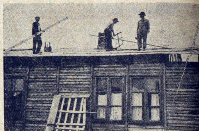
Osiedle pleszowskie powoli wraca do normalnego stanu, remontuje się uszkodzone baraki.
