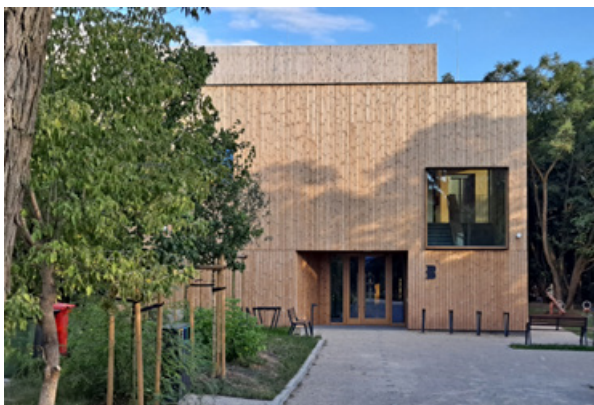
Il. 8. Widok biblioteki publicznej w Choszczówce w Warszawie autorstwa pracowni Ambient Magdaleny Pios, fot. Bartłomiej Homiński
