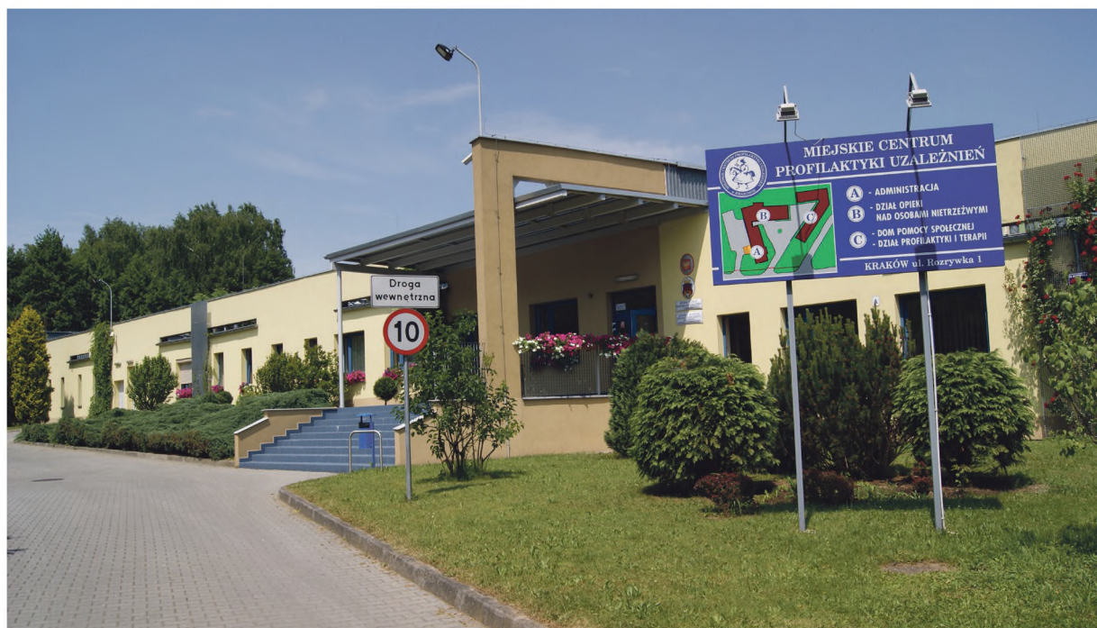
Fot. budynek MCPU
