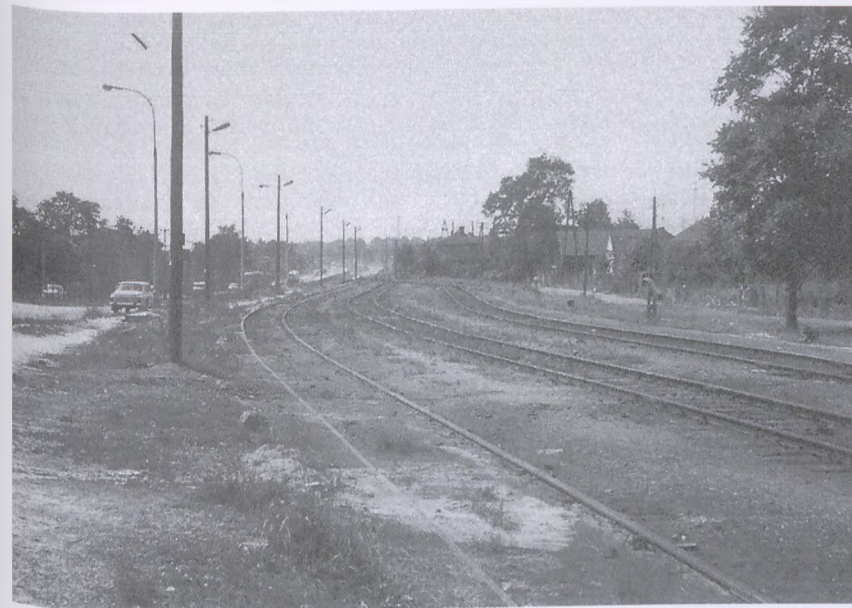
Stacja Czyżyny na wiosnę 1971 r. – widok w kierunku Wieczystej. Widoczne, częściowo rozebrane drewniane zabudowania stacyjne (bez baraku dworcowego), a w oddali stoi semafor wjazdowy. Fot. Jan Nikliński
