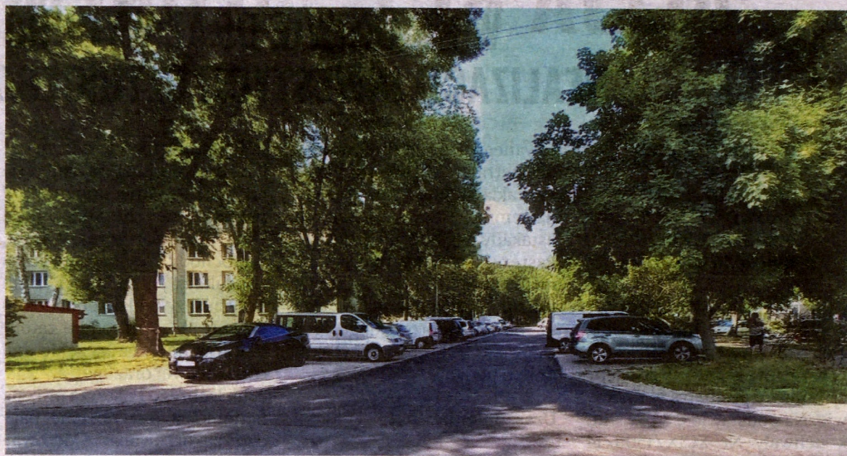
Zakończono już remont jezdni przy parkingu na osiedlu Strusia 2-3. Fot. Zygmunt Bińczycki
