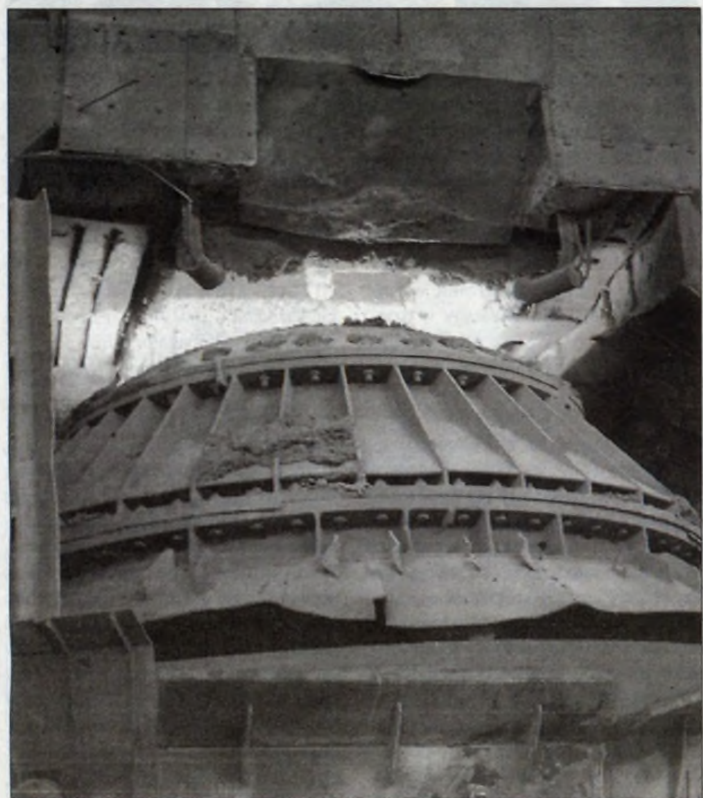
Zakres remontu pieca nie przewiduje jego modernizacji: będzie to remont odtworzeniowy.
