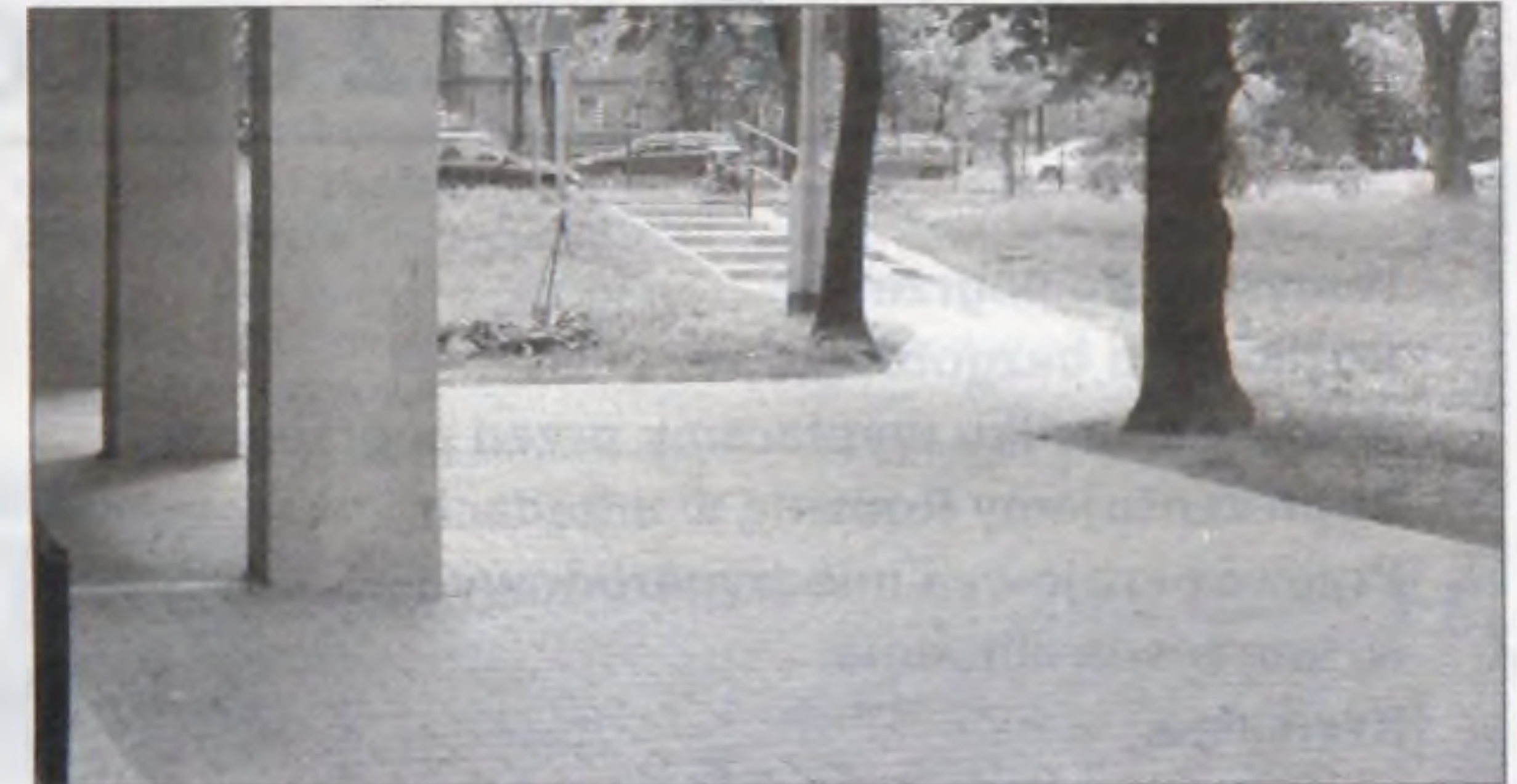
Nowy chodnik przy bloku nr 22 na os. Kolorowym.
