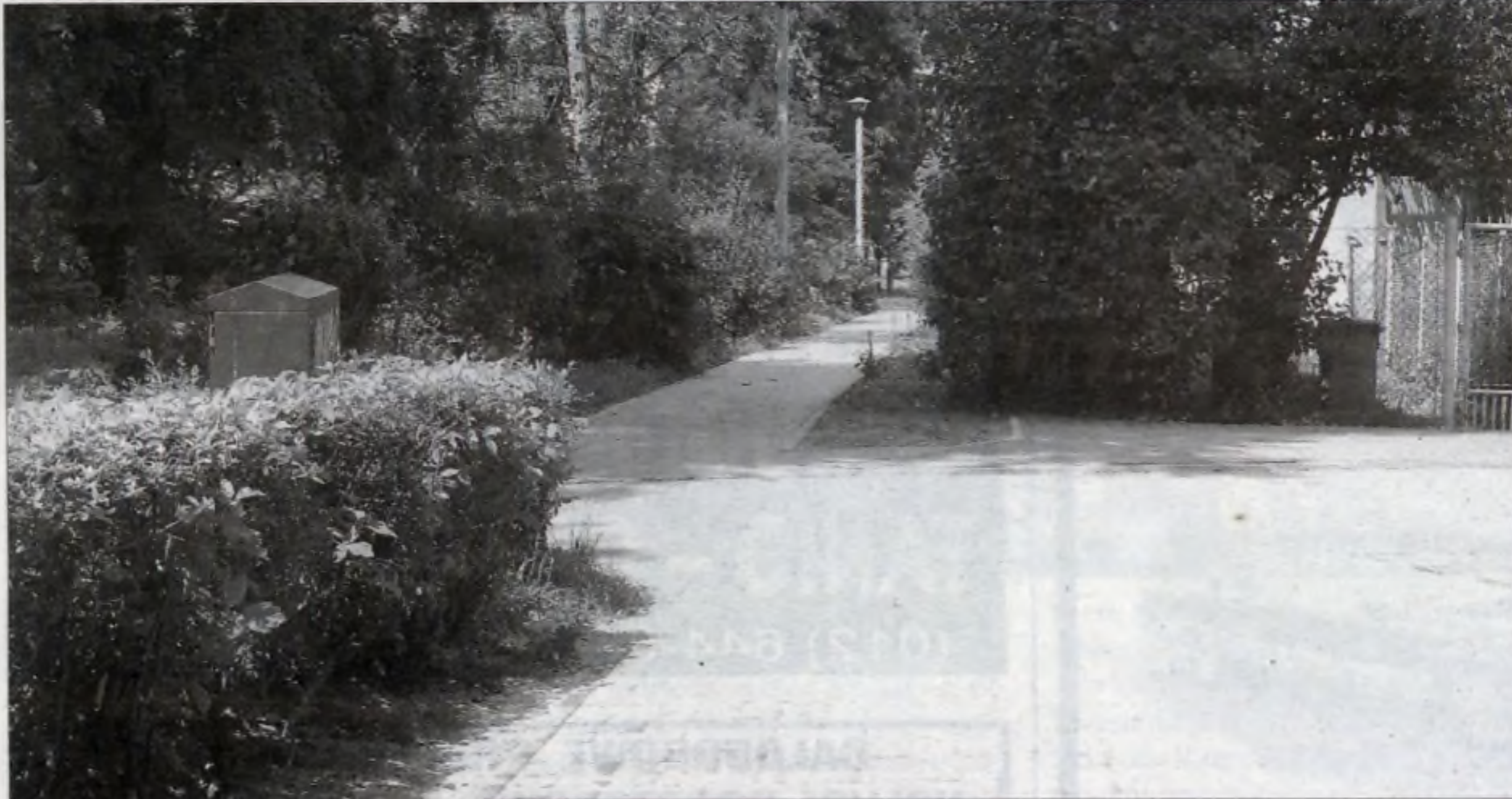
Wyremontowane chodniki w rejonie bloków 22 i 23 na os. Kolorowym.
