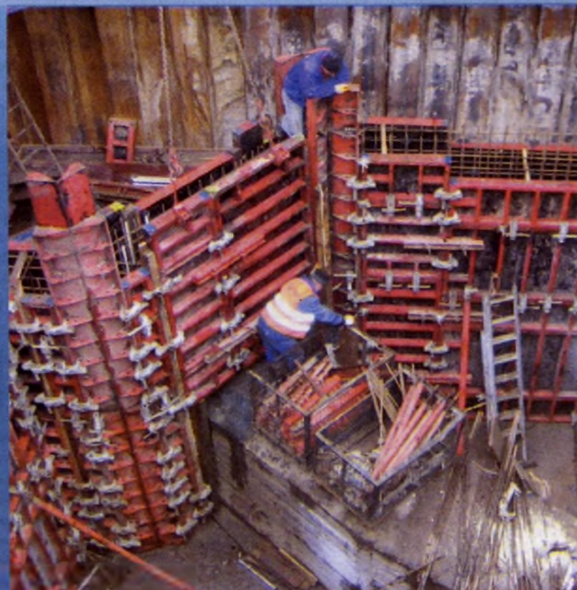
Prace przy budowie kolektora obciążeniowego w Nowej Hucie
