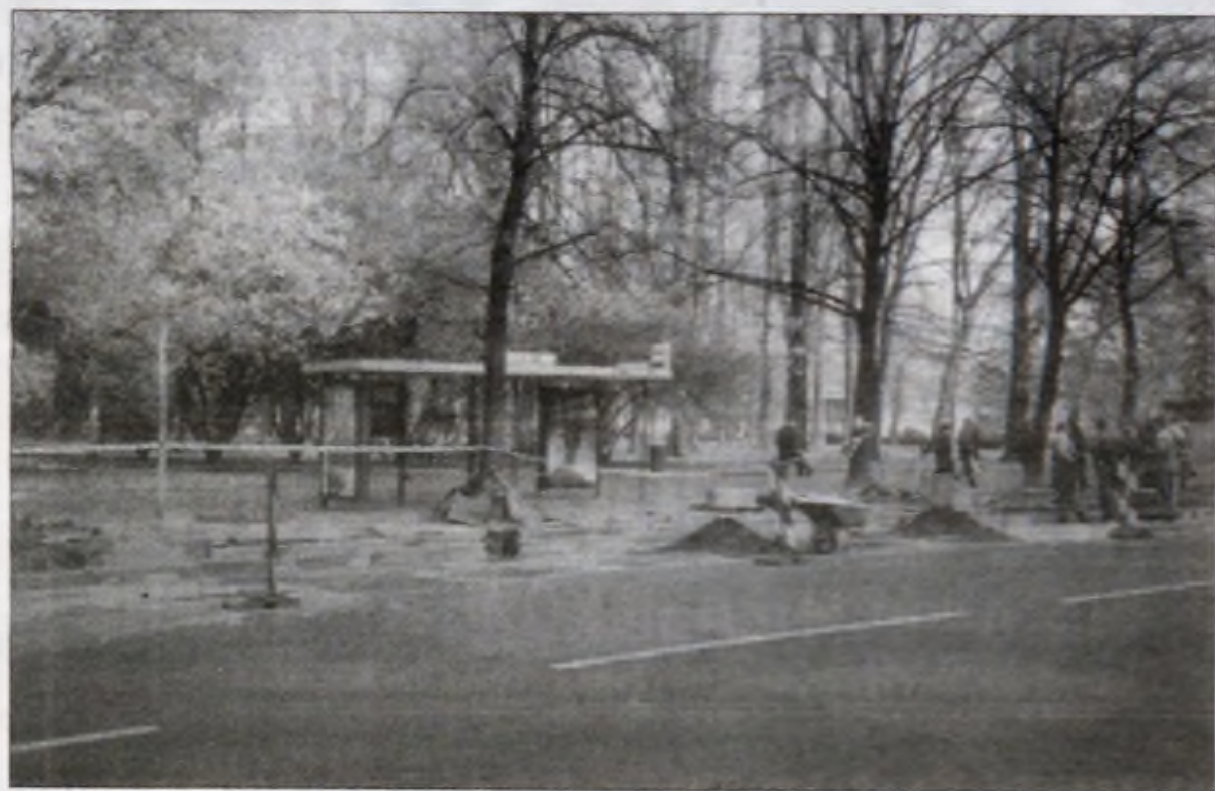
Remontowany przystanek przy Parku Ratuszowym.
