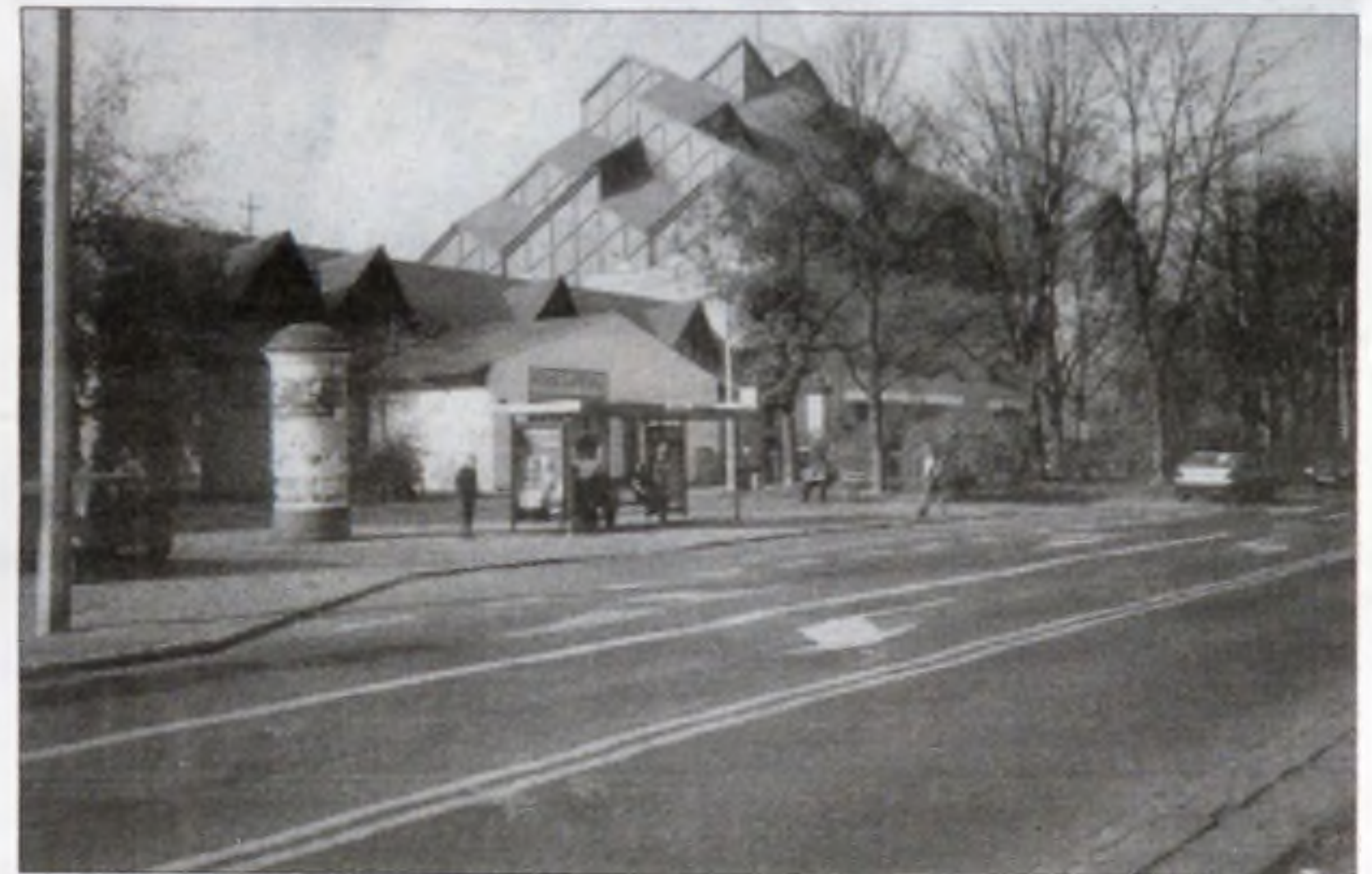
Ten przystanek na os. Szklane Domy także zostanie wyremontowany.
