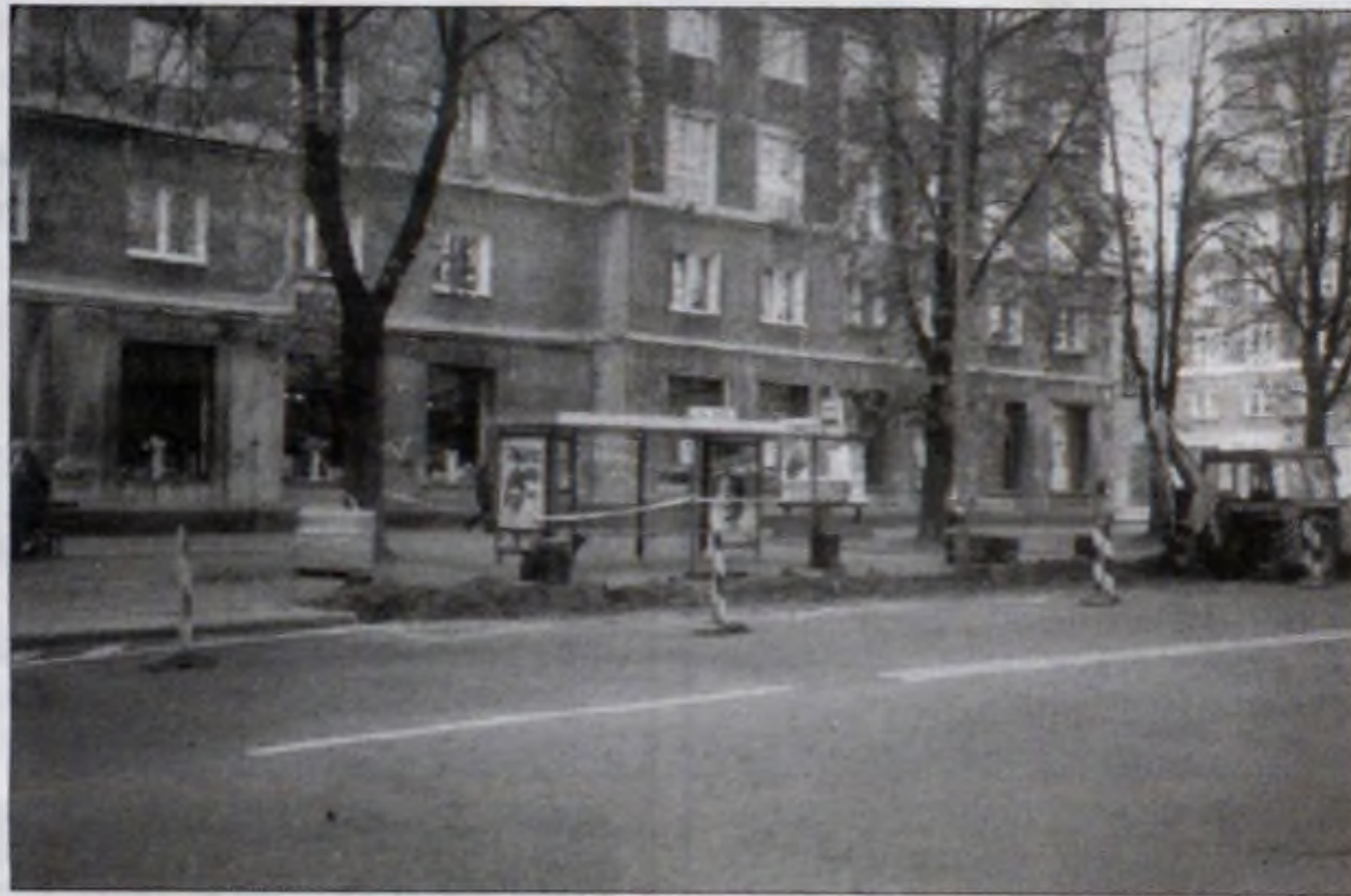
Remont przystanku autobusowego przy os. Centrum B.
