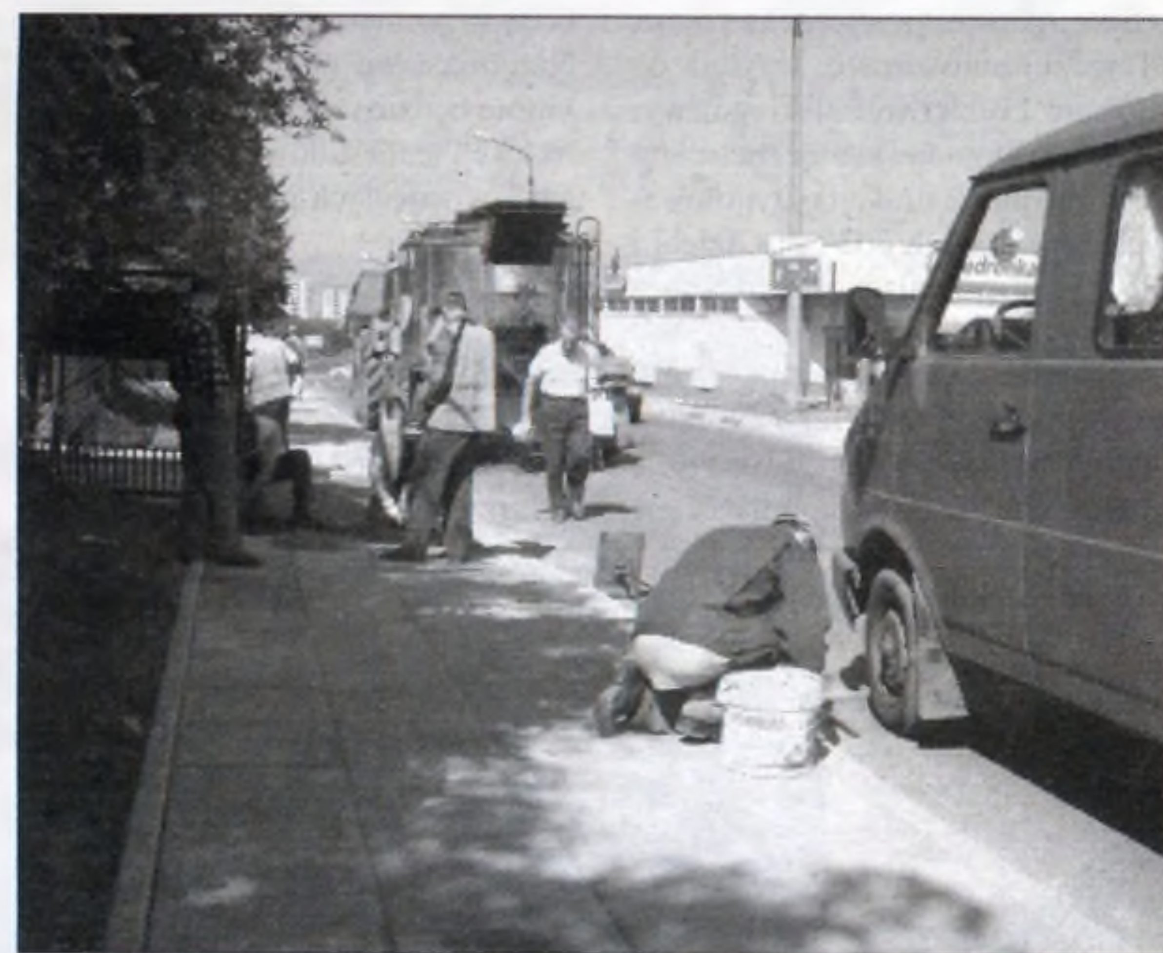
Remont przy ul. Książna.
