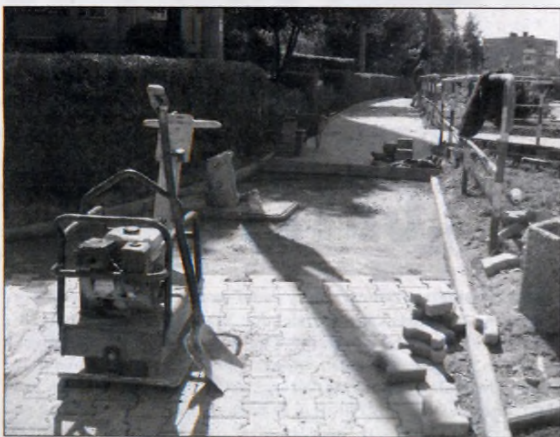
Remont przy bloku 12.
