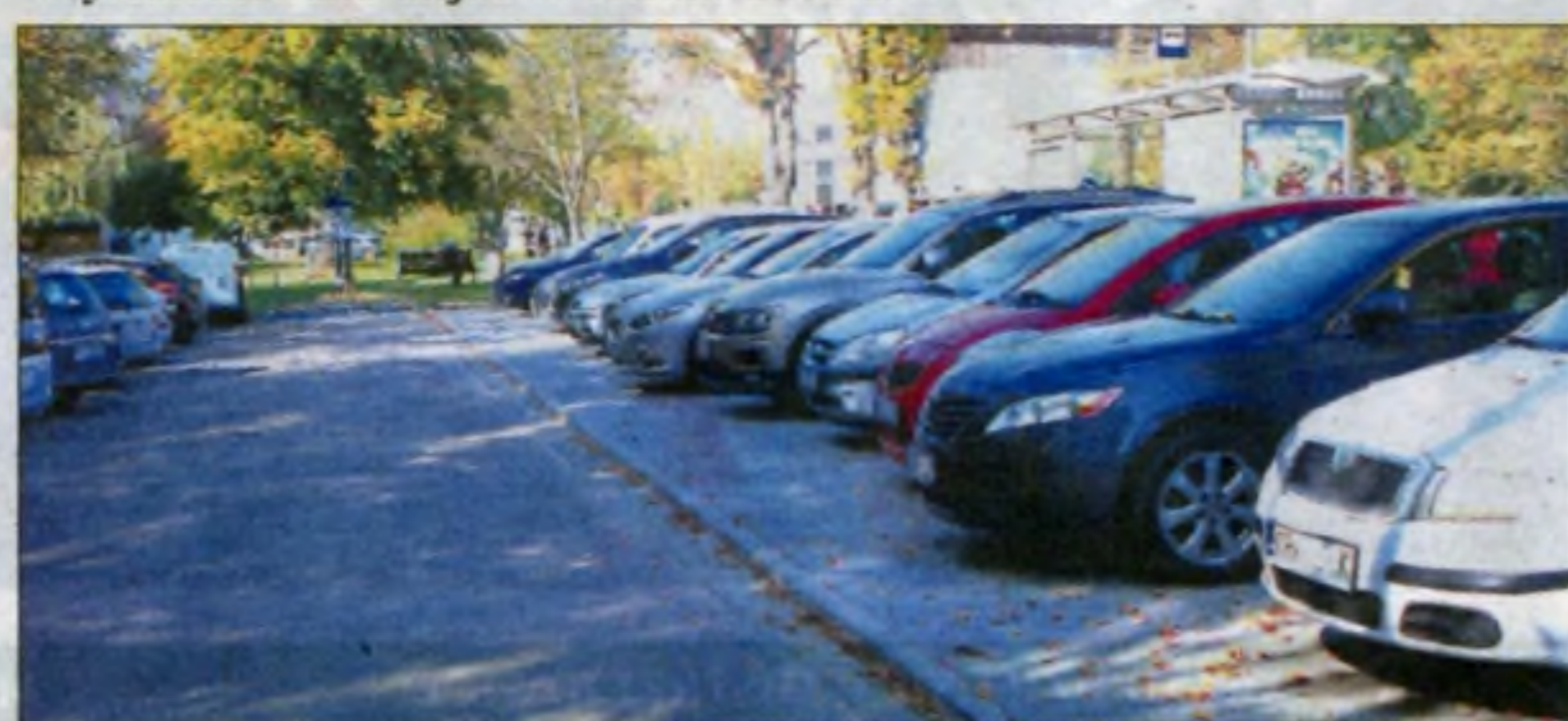
Parking w osiedlu Przy Arce, przed blokiem nr 12 – po remoncie.
