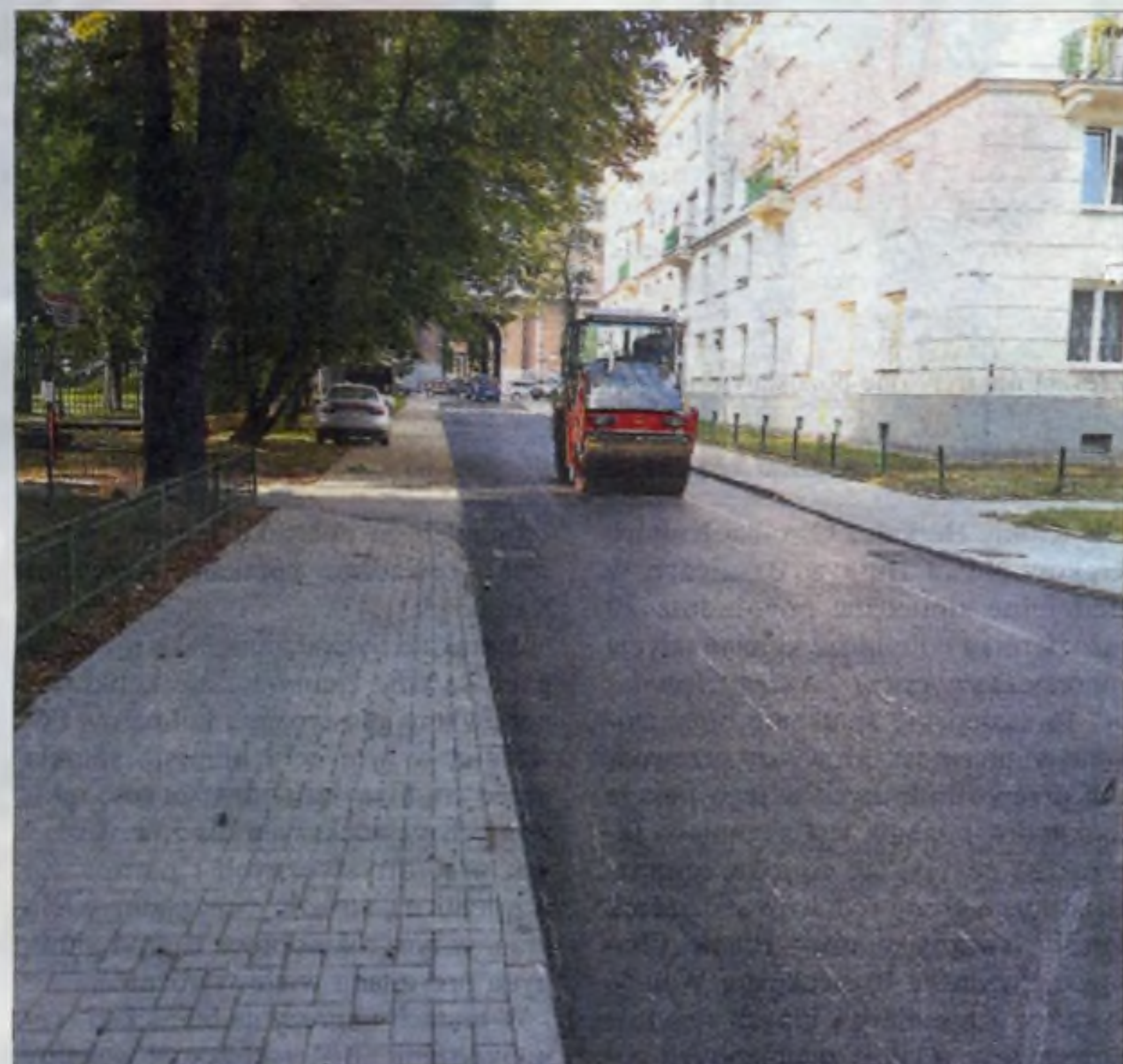
Nowa nakładka asfaltowa na os. Stalowym przy bloku nr 9.
