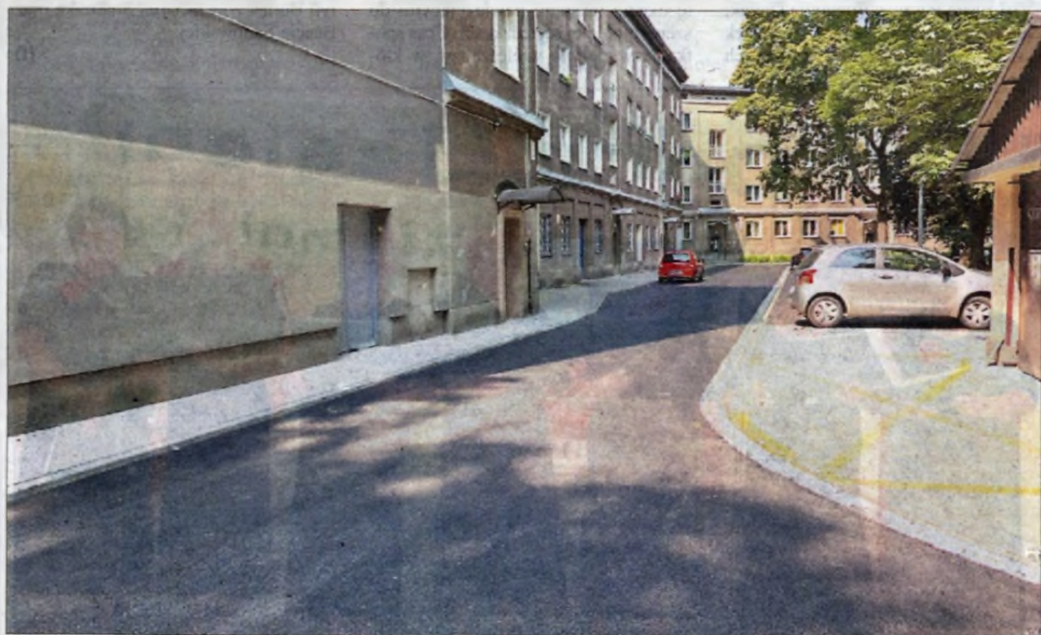
Os. Szkolne 11 i 12 – nowa nakładka asfaltowa oraz wyremontowane chodniki.
