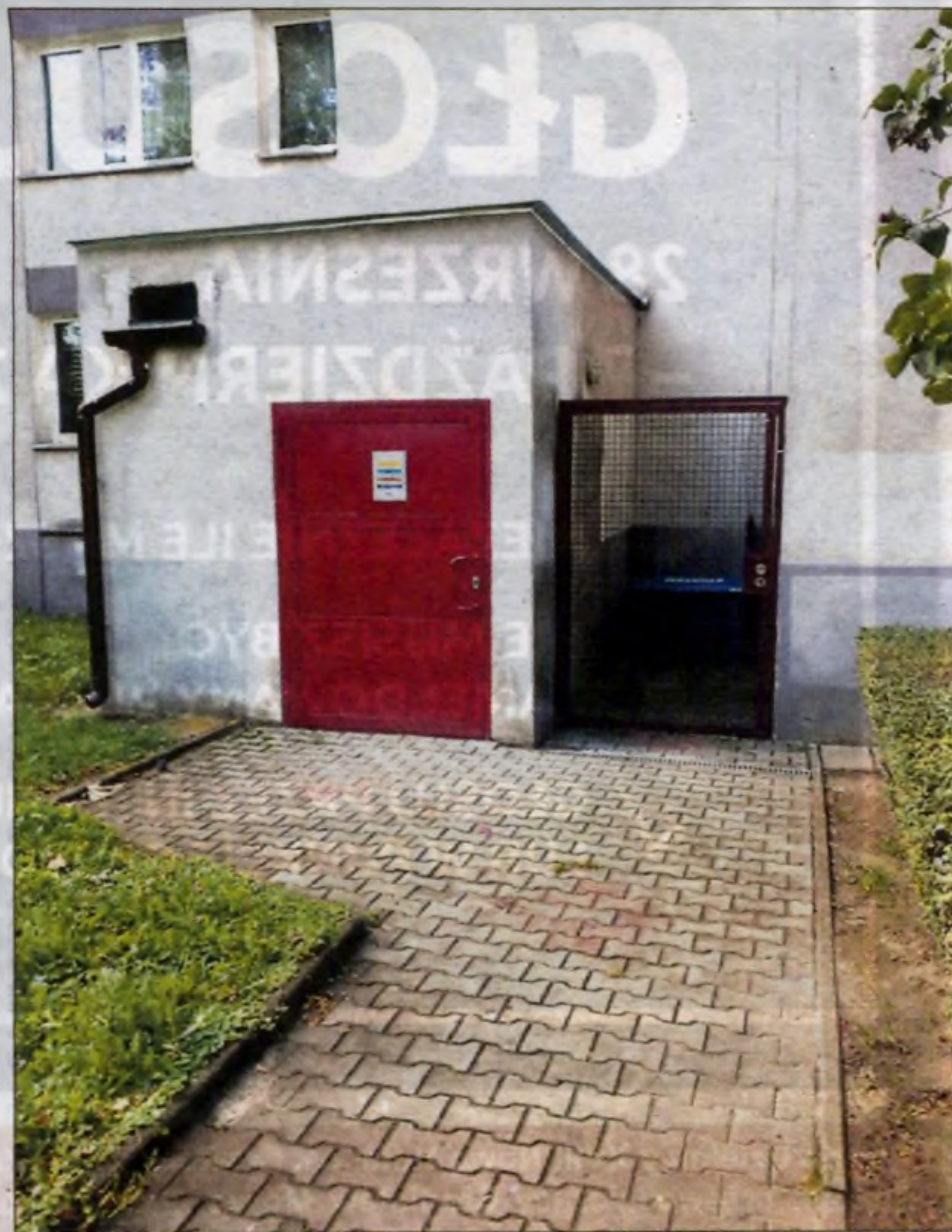
Komora zsympowa przy budynku.
