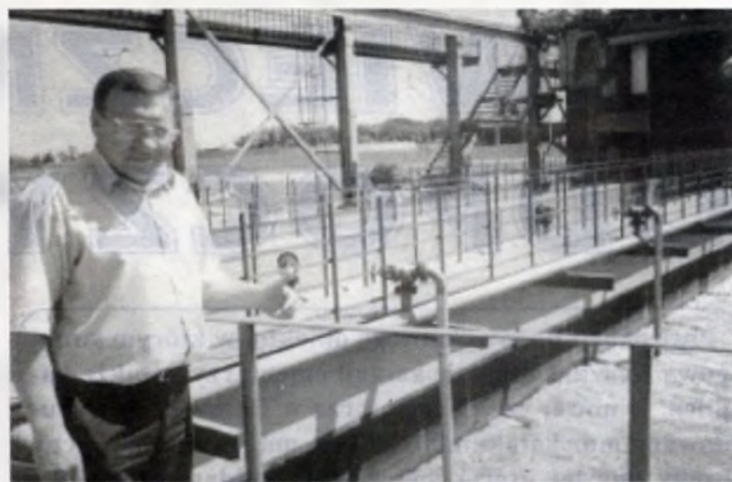
Kierownik Jan Ziętara wyjaśnia działanie separatora zanieczyszczeń grubych.
