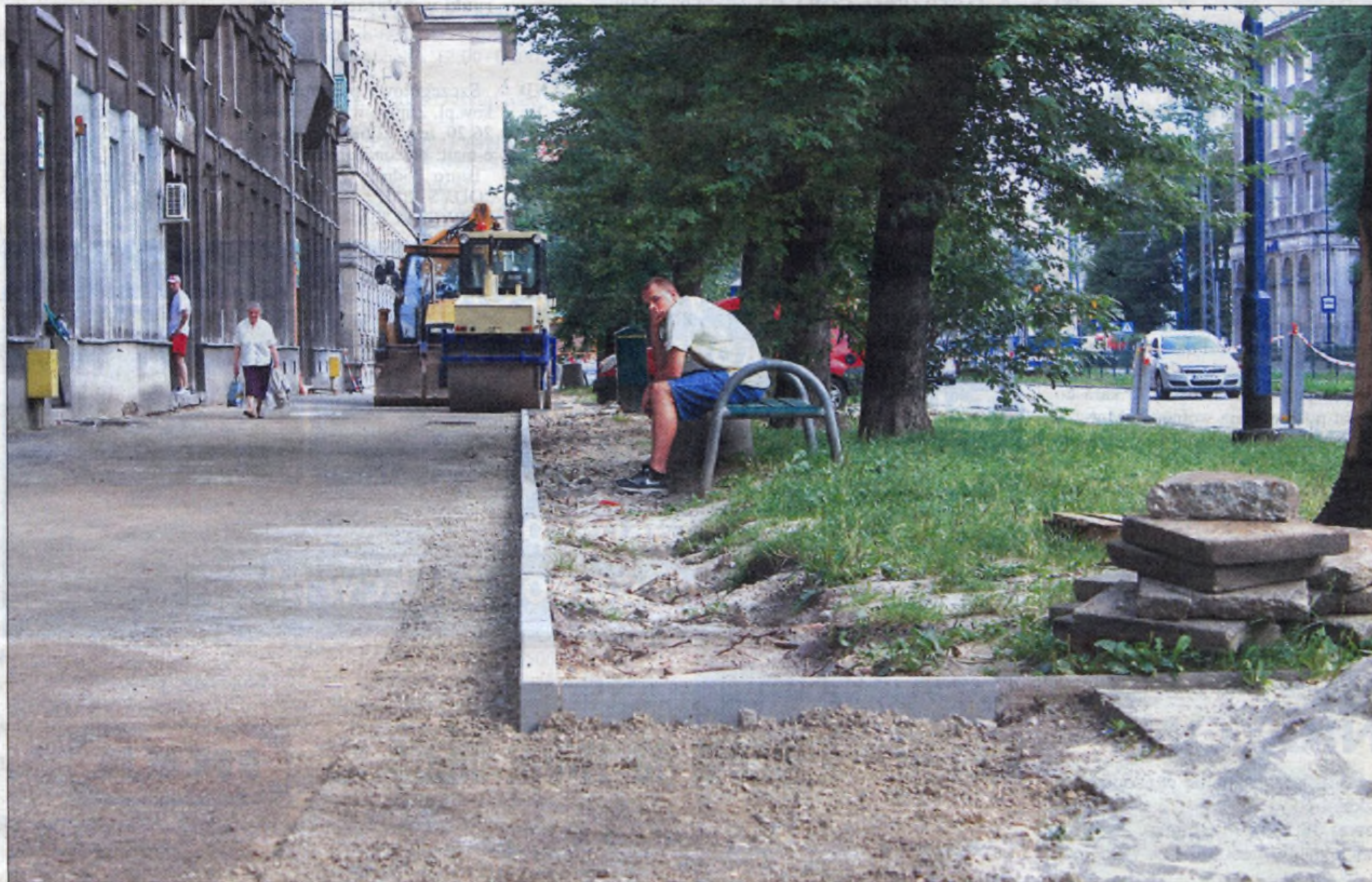
Trwa remont chodnika wzdłuż Al. Andersa. Na co zostaną wymienione chybotać się duże płytki.
