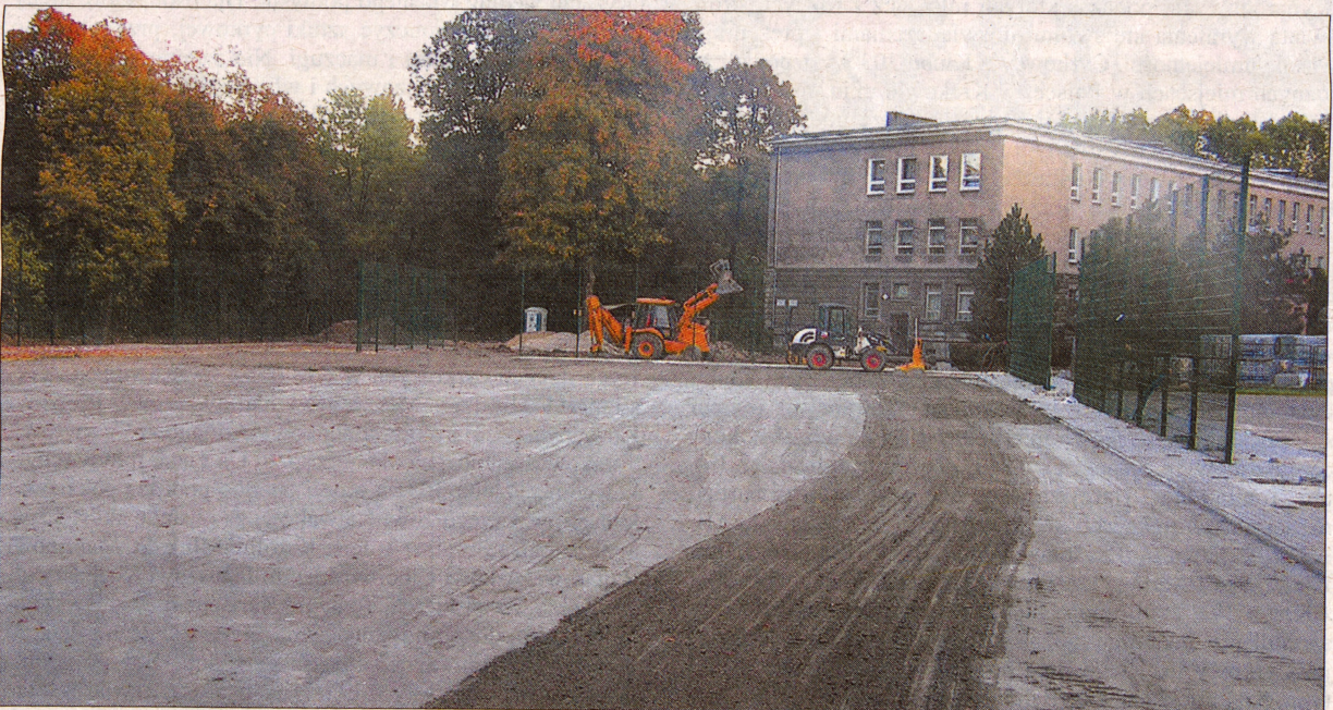
Budowa boiska wielofunkcyjnego przy Szkole Podstawowej nr 37.
