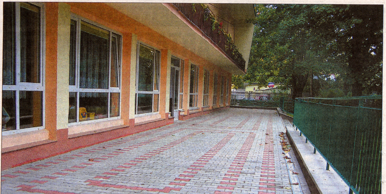
Wyremontowany taras w Przedszkolu nr 105
