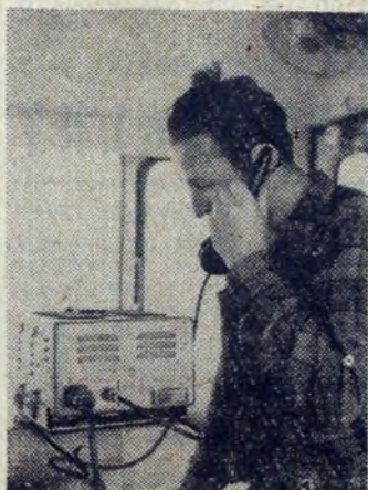
A oto jeszcze coś z podwórka postępu technicznego i nowoczesności w transporcie: łączność przy pomocy radiotelefonu. Aparat za instalowany jest w kabinie lokomotywy.
